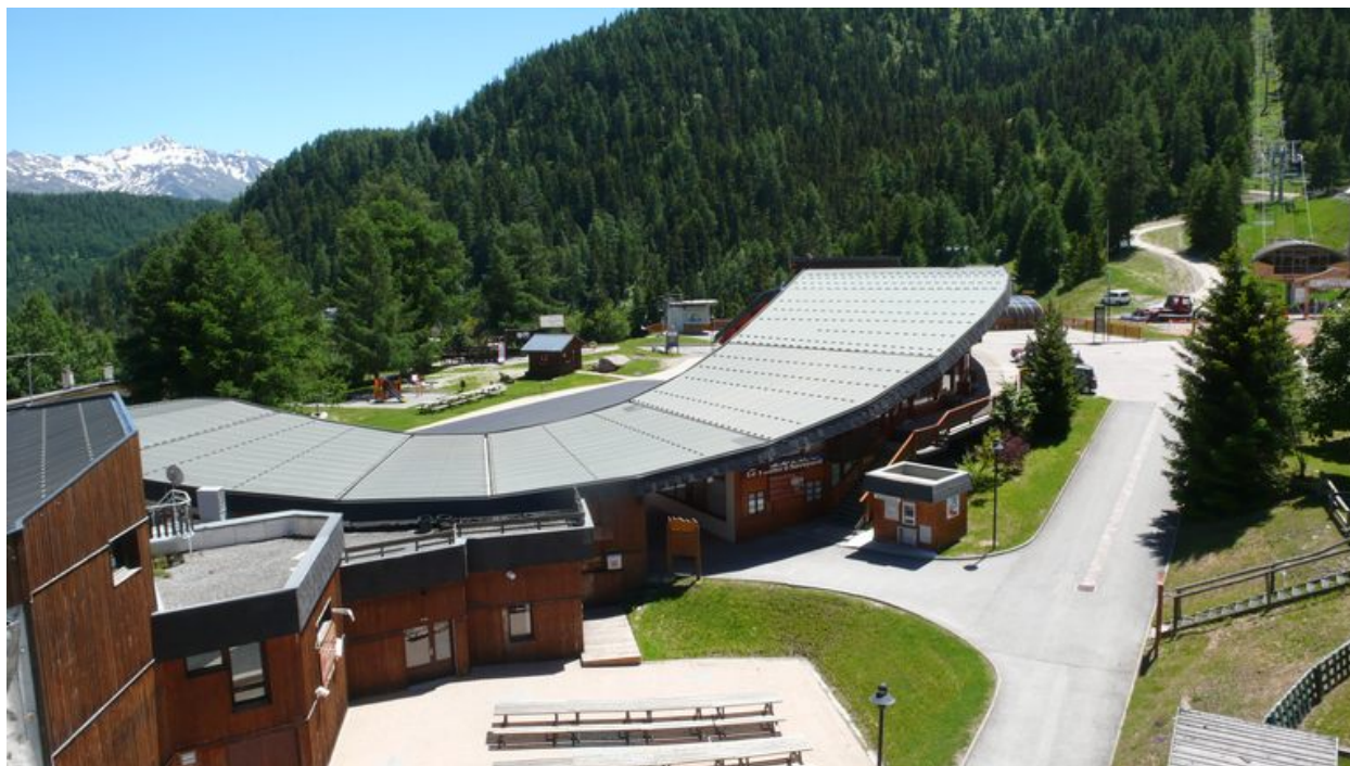
Vue d'ensemble depuis le nord-ouest, la salle de spectacle à gauche
