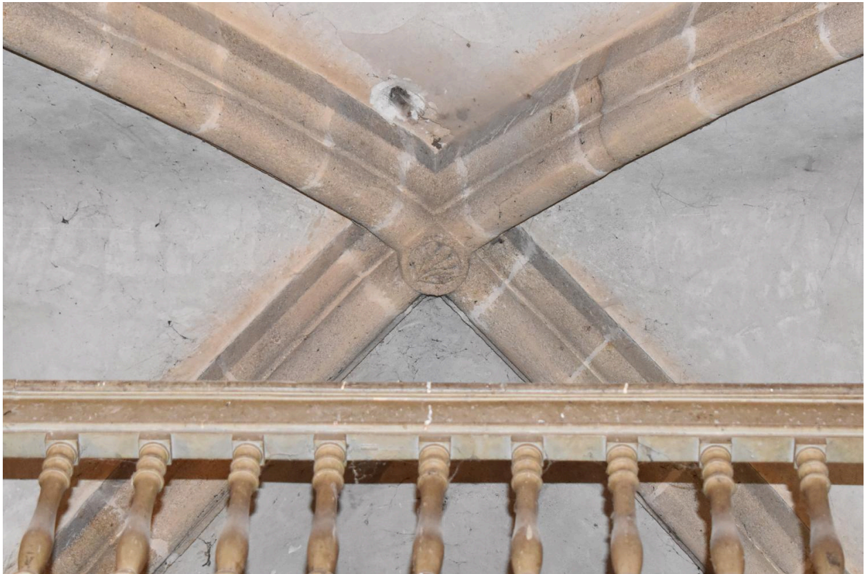
Détail de la croisée d'ogives à clef de voûte sculptée de feuillages de la première travée de la nef.
