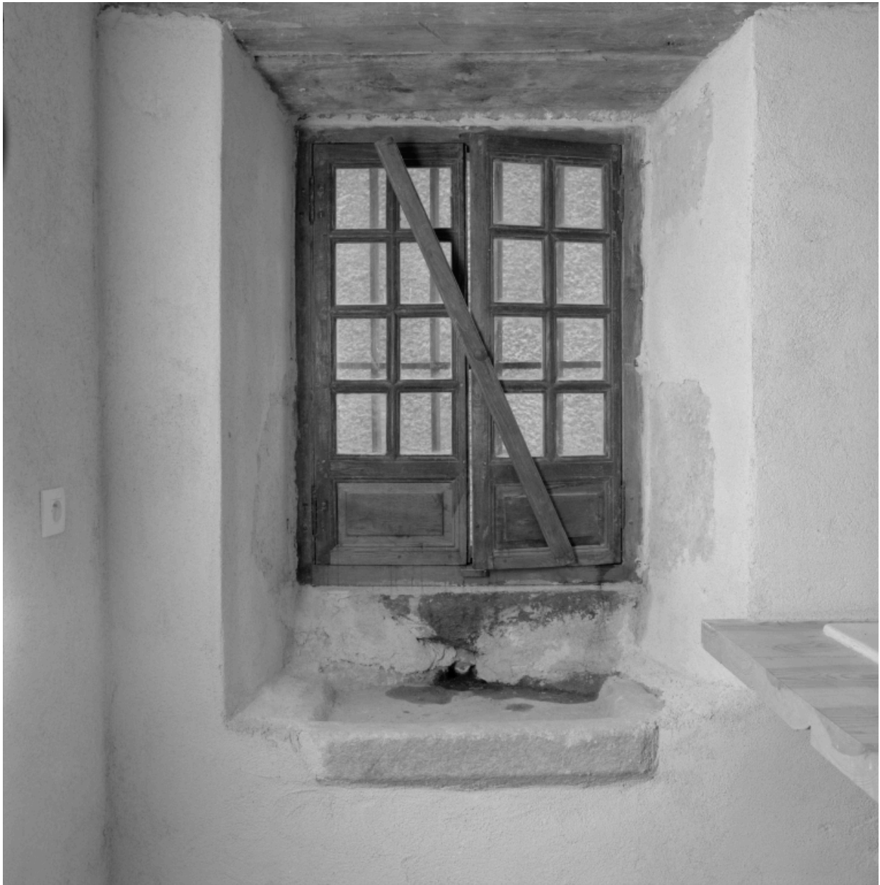
Détail de la fenêtre de la cuisine.
