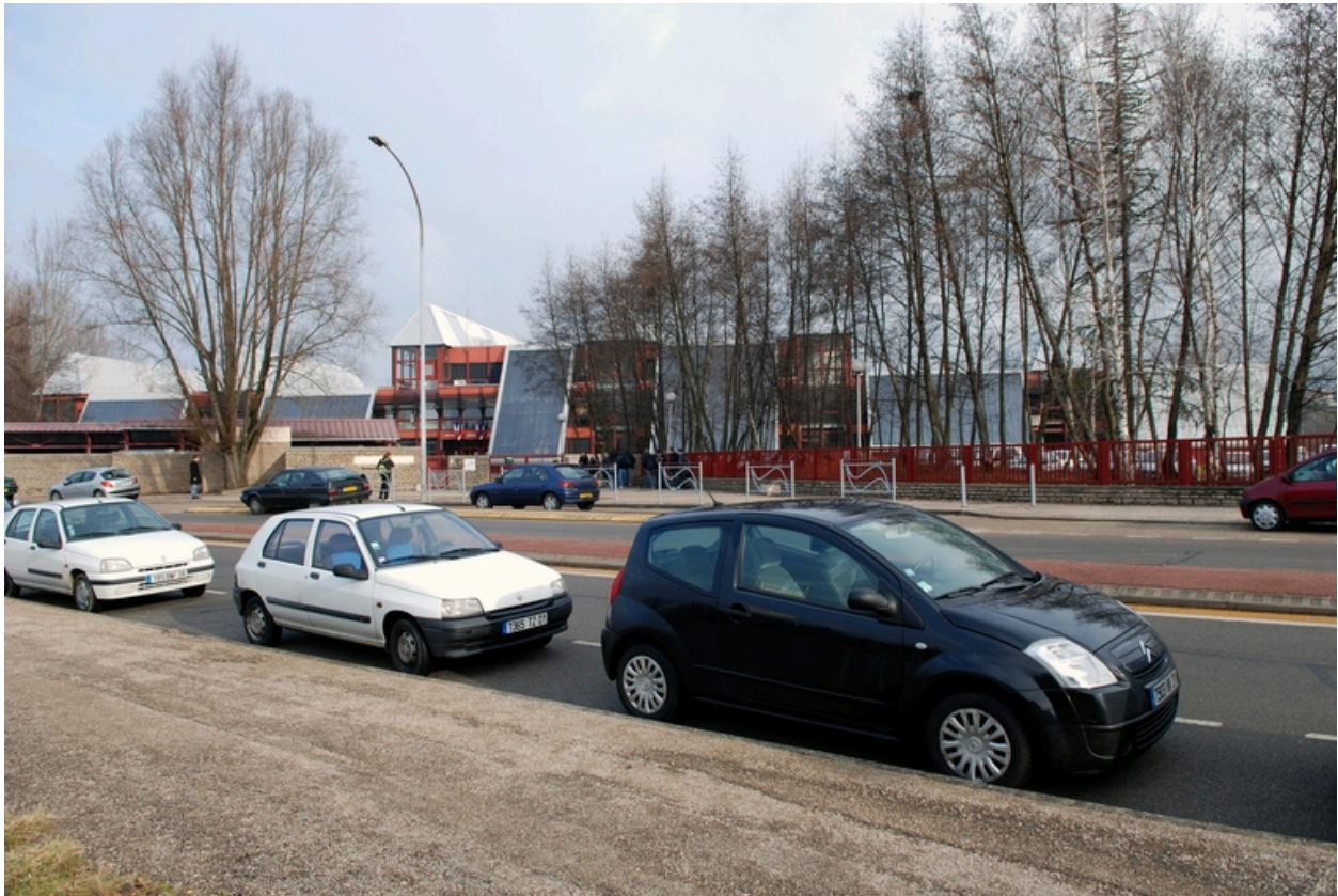
Bâtiment A. Vue d'ensemble depuis le sud-est
