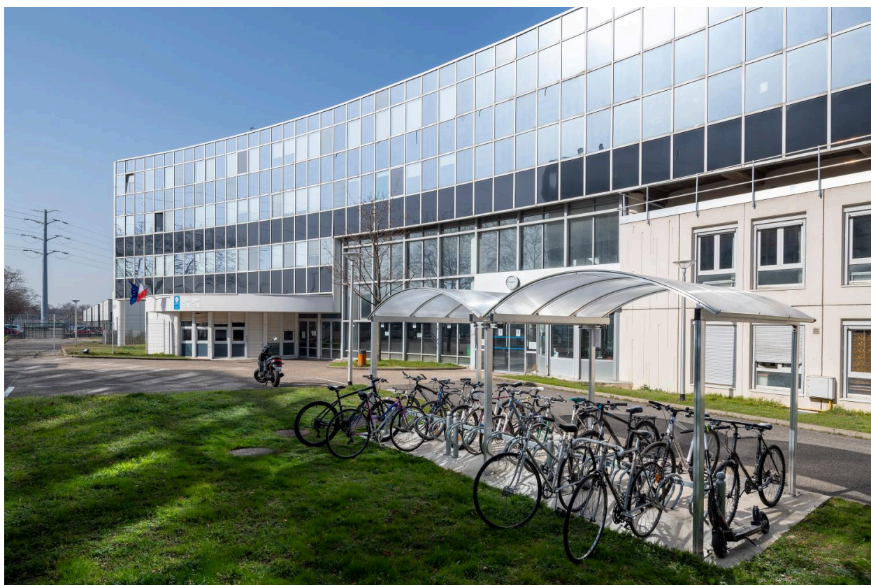
Vue du bâtiment principal
