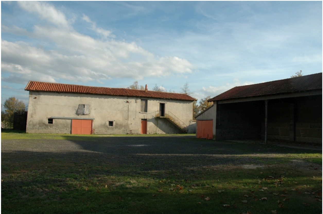
Vue d'ensemble de l'élévation antérieure, sur cour, de l'étable orientale.
