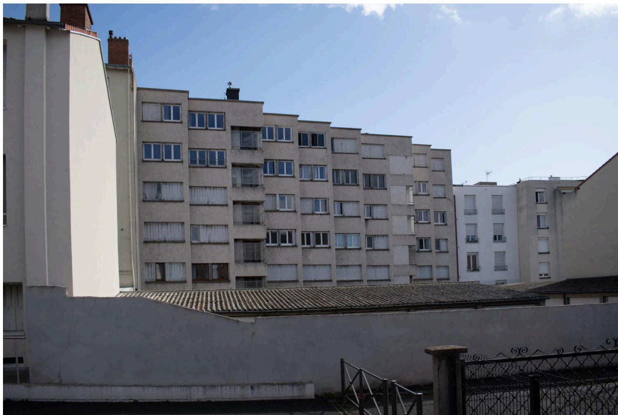
Élévation postérieure, vue depuis le chemin de Beaurepaire
