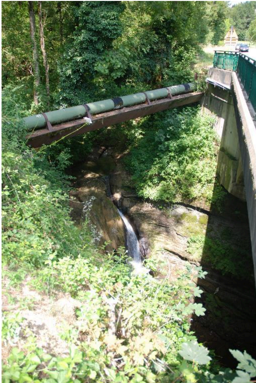
Vue du pont de la Monderesse, Chez Prima (près du moulin de la Verdasse).
