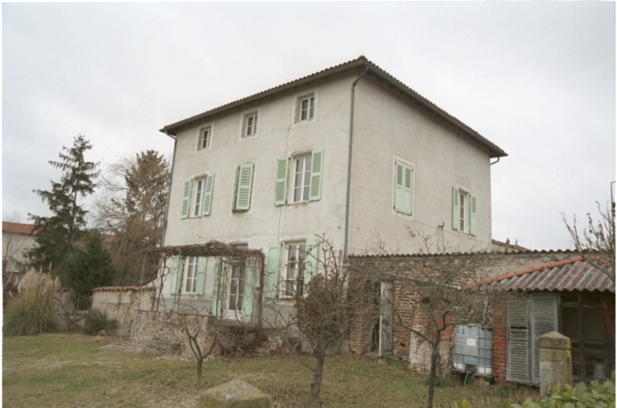
Vue d'ensemble de la façade latérale gauche (sur jardin, côté sud).
