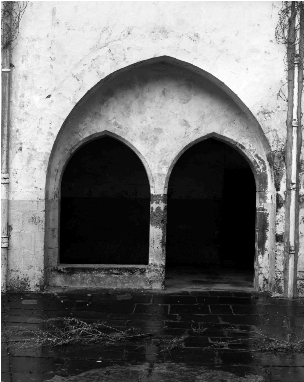
Cloître, galerie ouest, deux baies libres, dont une sur bahut, groupée sous un arc brisé.
