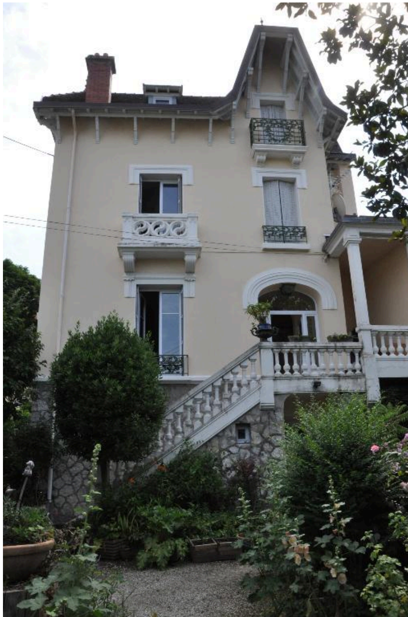
Elévation principale orientée à l'ouest
