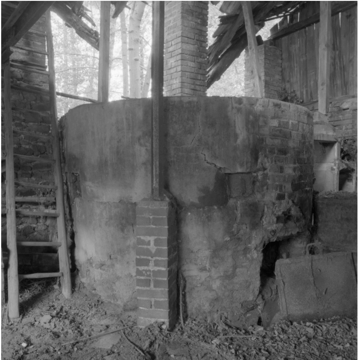
Vue d'ensemble du four pour le chauffage de l'eau pour les bains (?)
