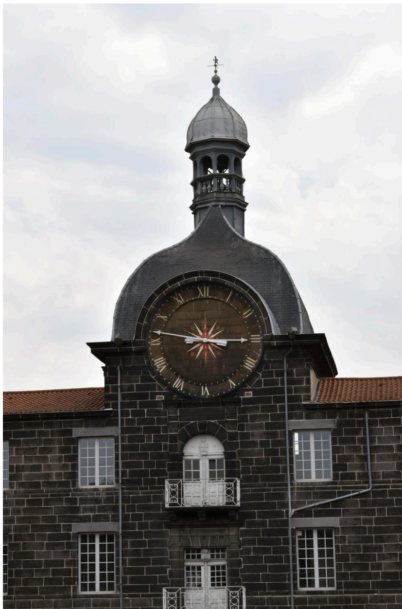
Pavillon central : détail du dôme et de l'horloge
