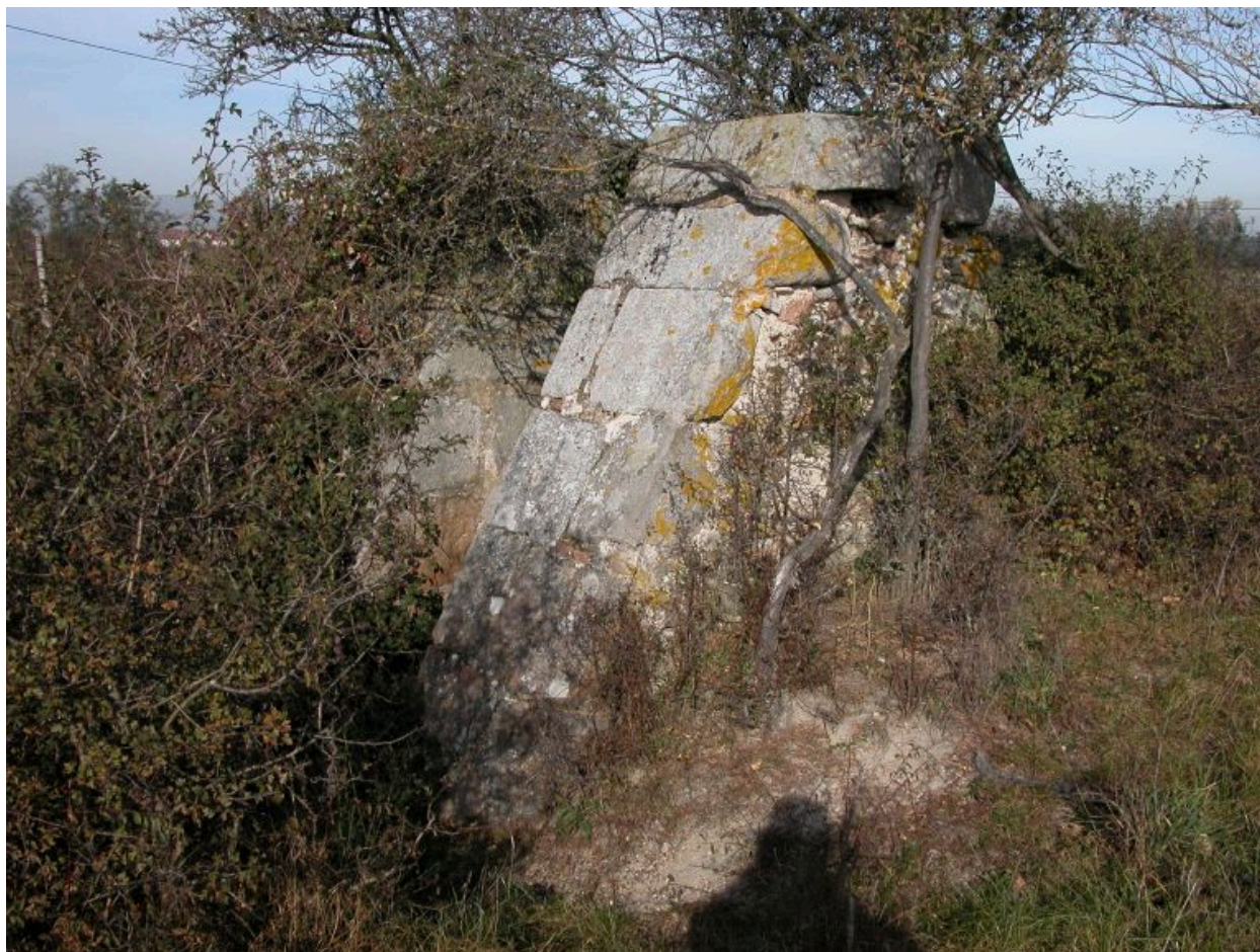
Sous Grumard, 1986 AP 23. Massifs maçonnés non identifiés.
