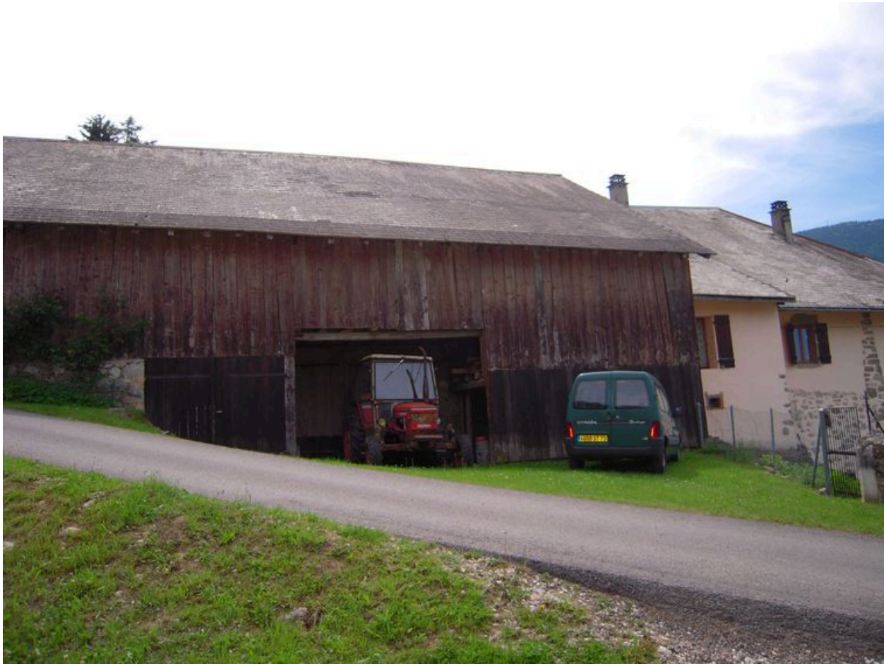
Vue de la grange depuis la façade nord.
