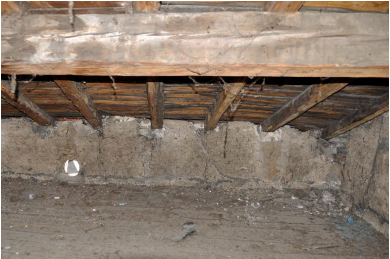
Vue de l'étage de comble, mur gouttereau en pisé
