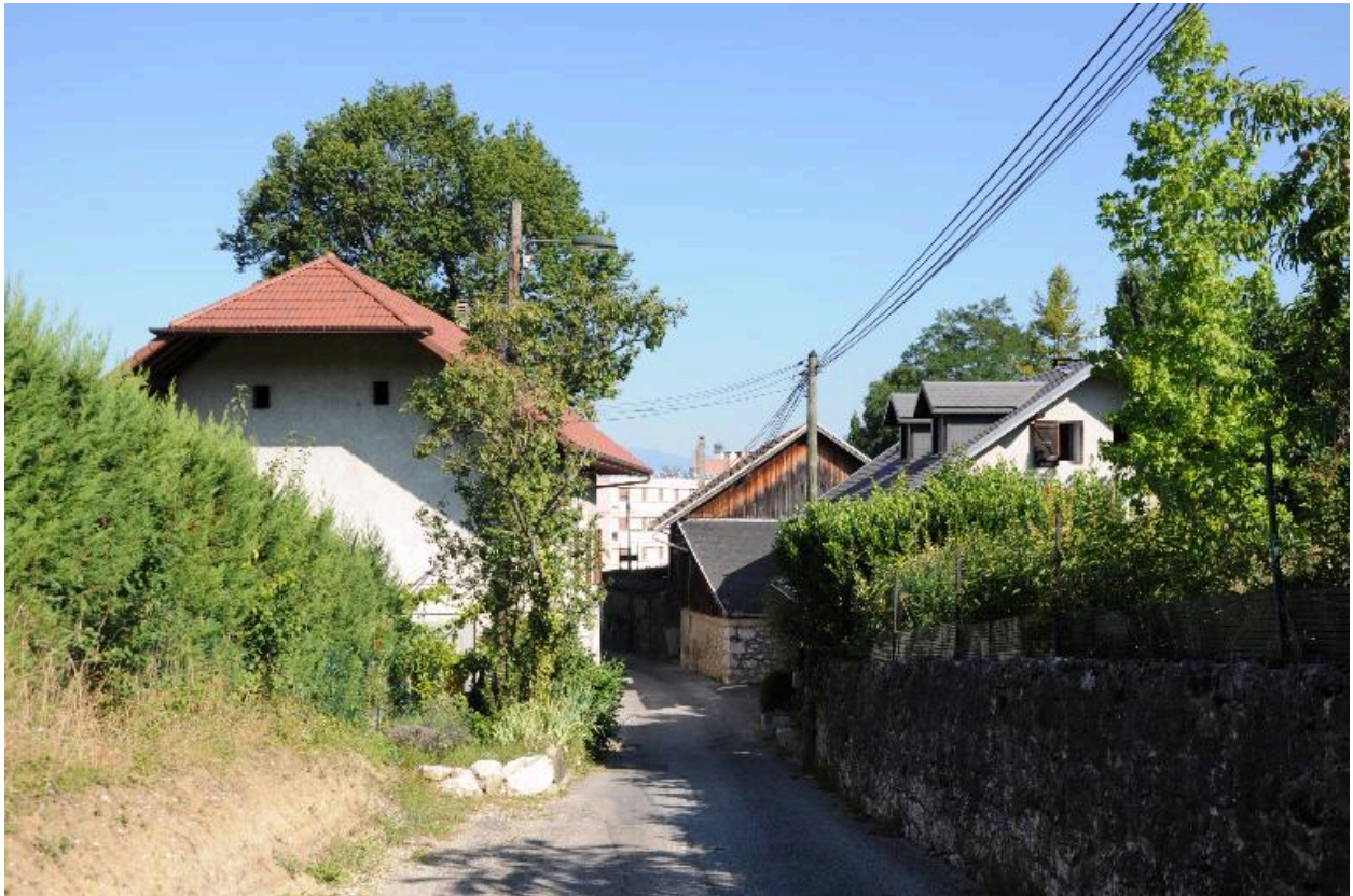
Vue d'ensemble: à droite l'ancienne grange
