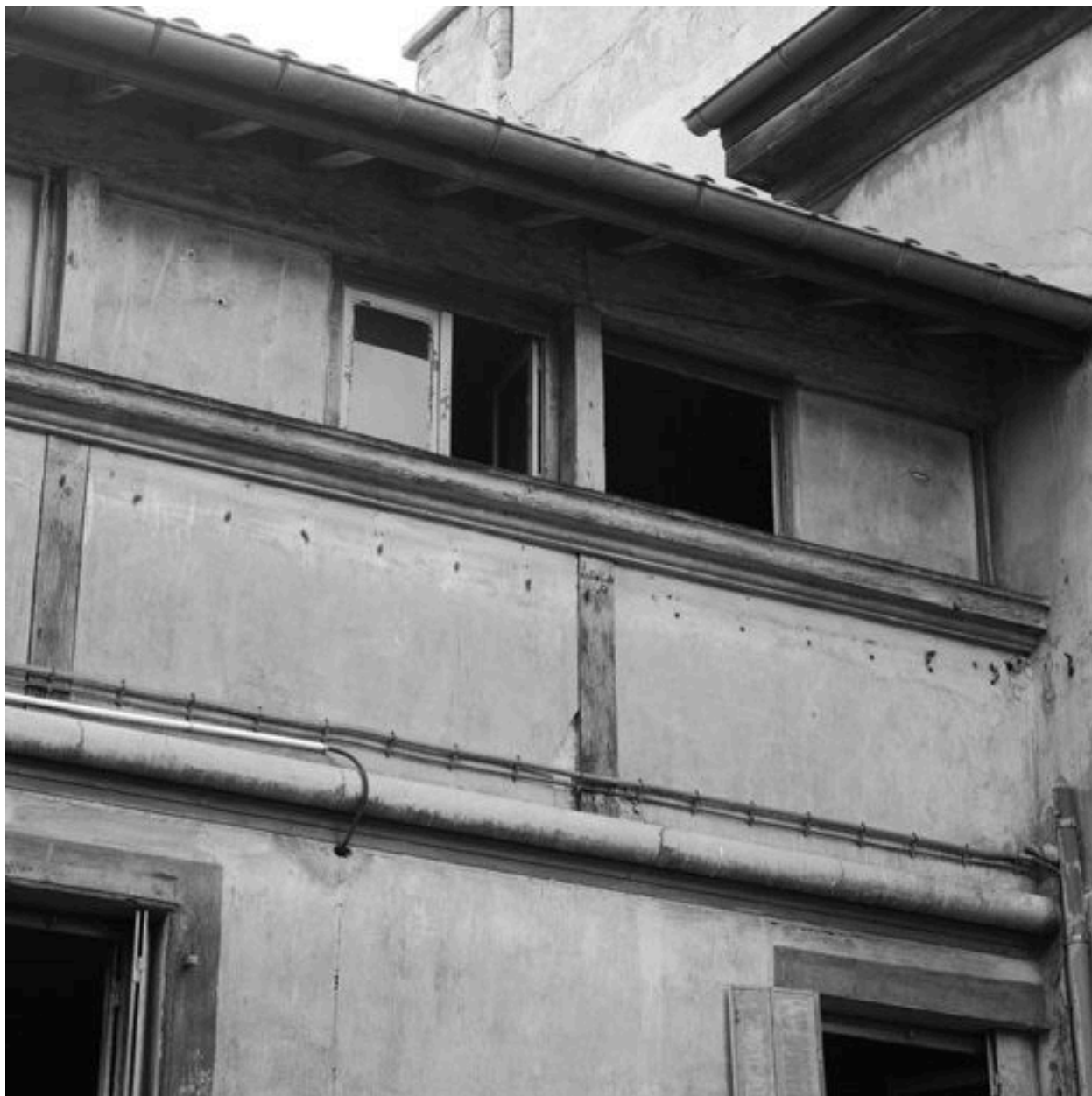
Corps de bâtiment nord. Façade sur cour. Détail des baies du dernier niveau
