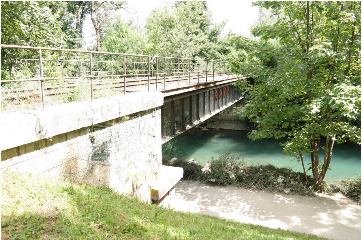
Ancien pont ferroviaire de Cran, vue de la face amont
