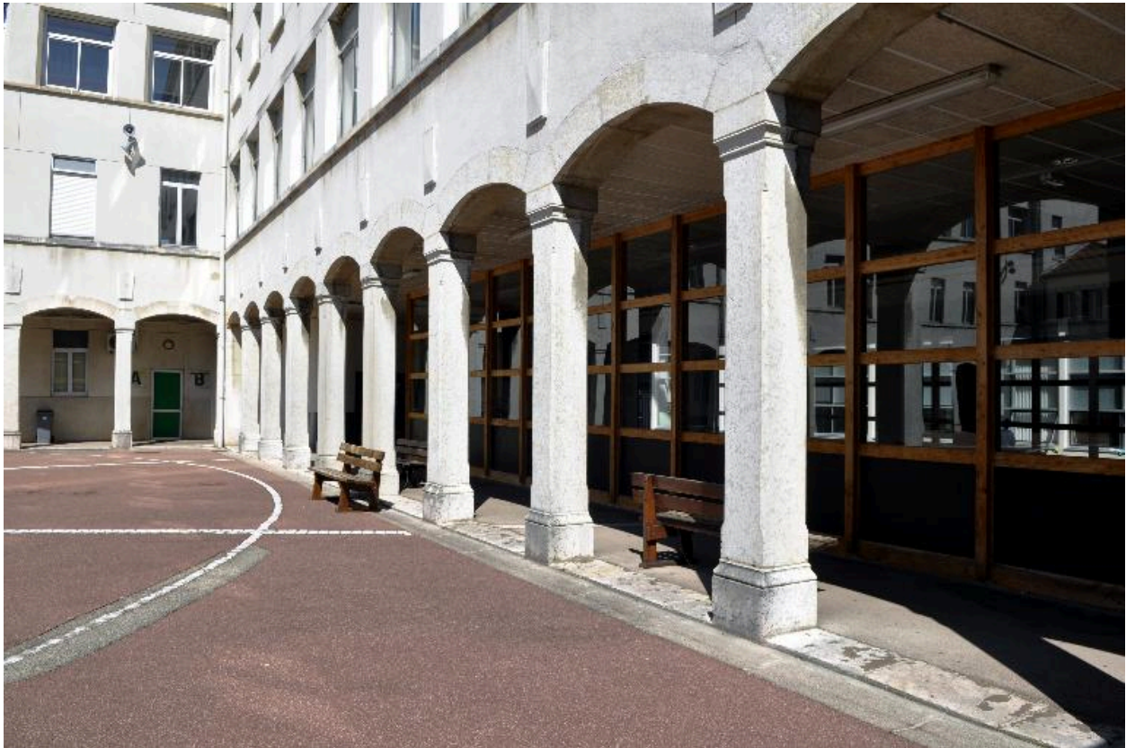
Grande cour, galerie longeant le bâtiment B, depuis le sud
