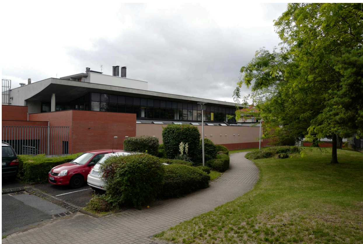
Elévation occidentale, sur le cheminement piéton de la résidence Lavoisier
