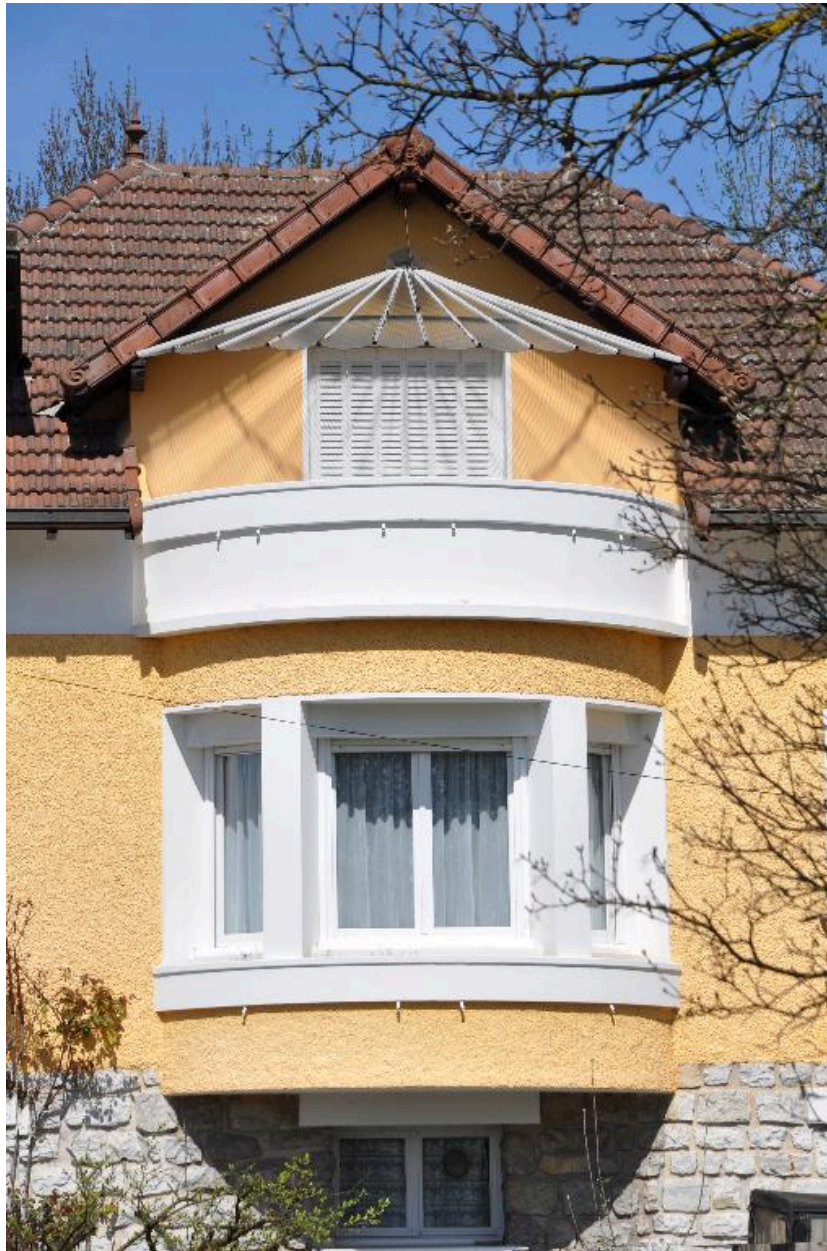
Détail sur le bow-window de la façade principale
