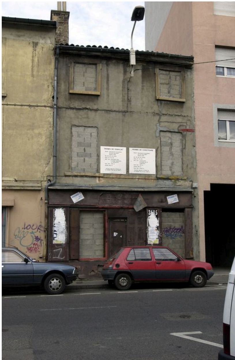
Façade du n° 151, bâtiment existant en 2001
