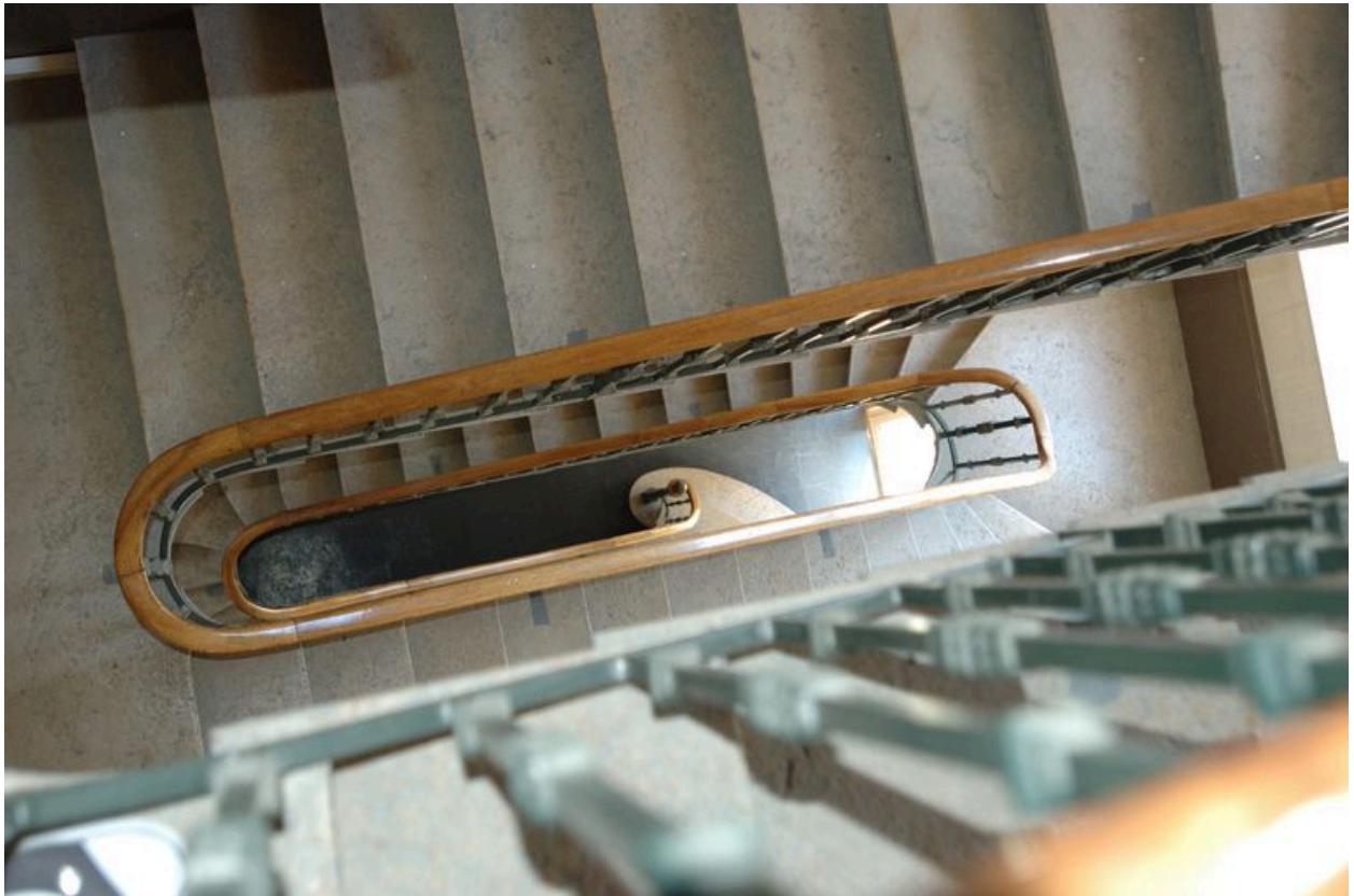
Détail de l'escalier de l'ancien bâtiment de la communauté des soeurs.
