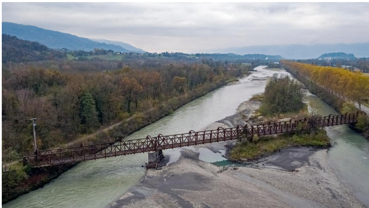
Vue d'ensemble du Pont des Anglais à Cruet
