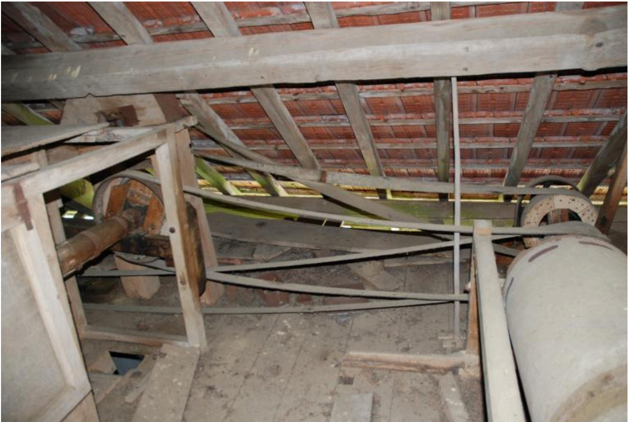
Vue intérieure du comble, partie nord : courroies et poulies.
