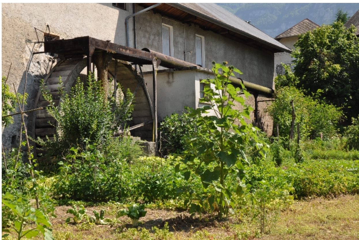
Vue de la roue métallique verticale avec son arrivée d'eau (canal et conduite forcée)
