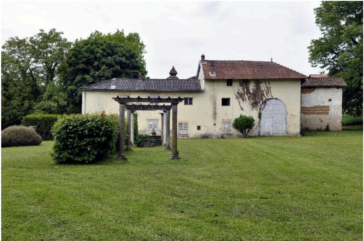
Ferme Jacou : vue d'ensemble depuis le nord-est, pergola
