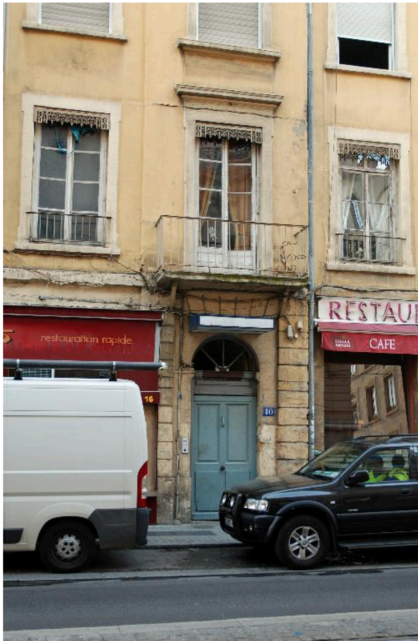
Vue rapprochée de la porte d'entrée surmontée d'un balcon
