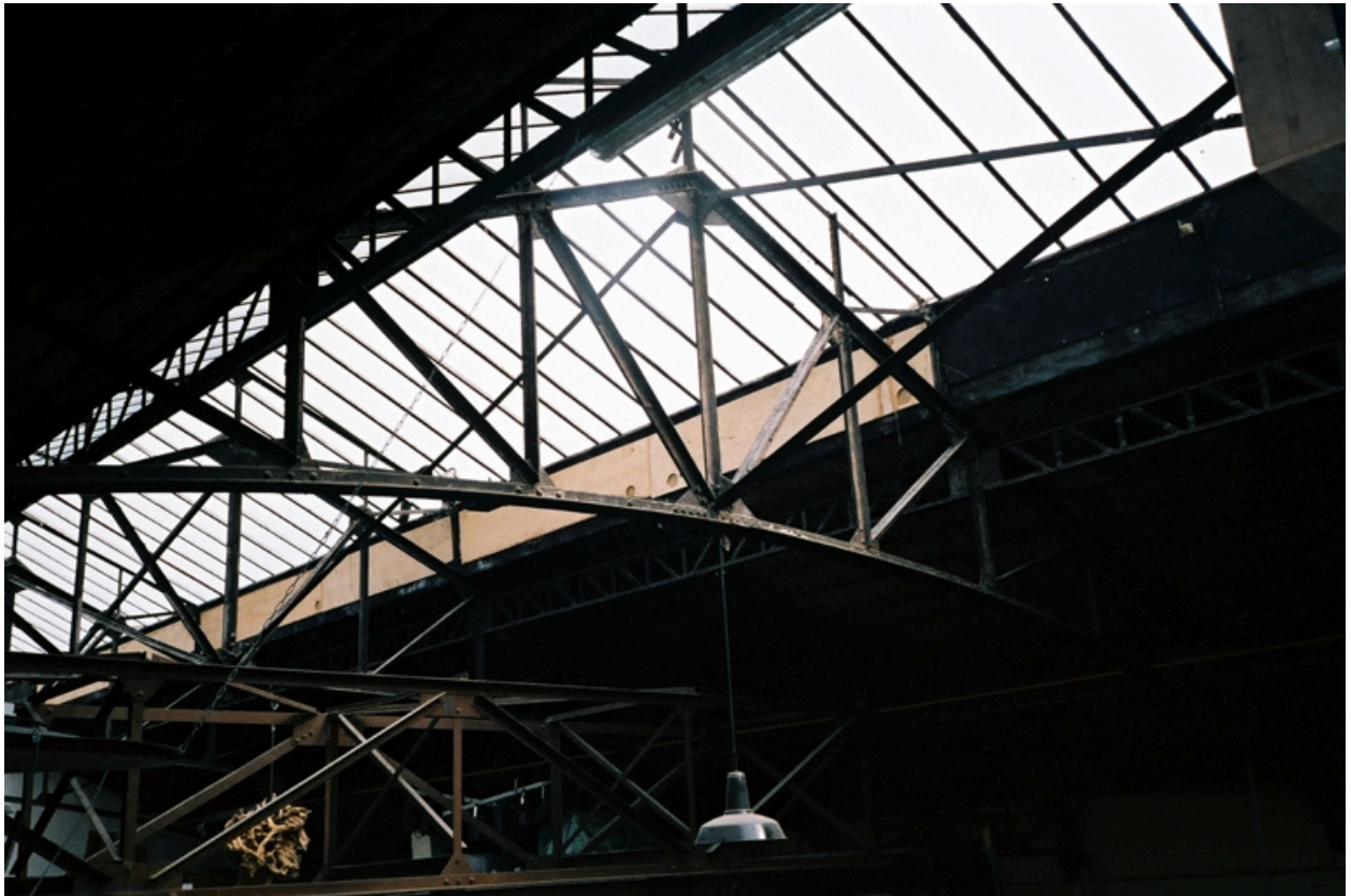
Lanterneau et charpente métallique
