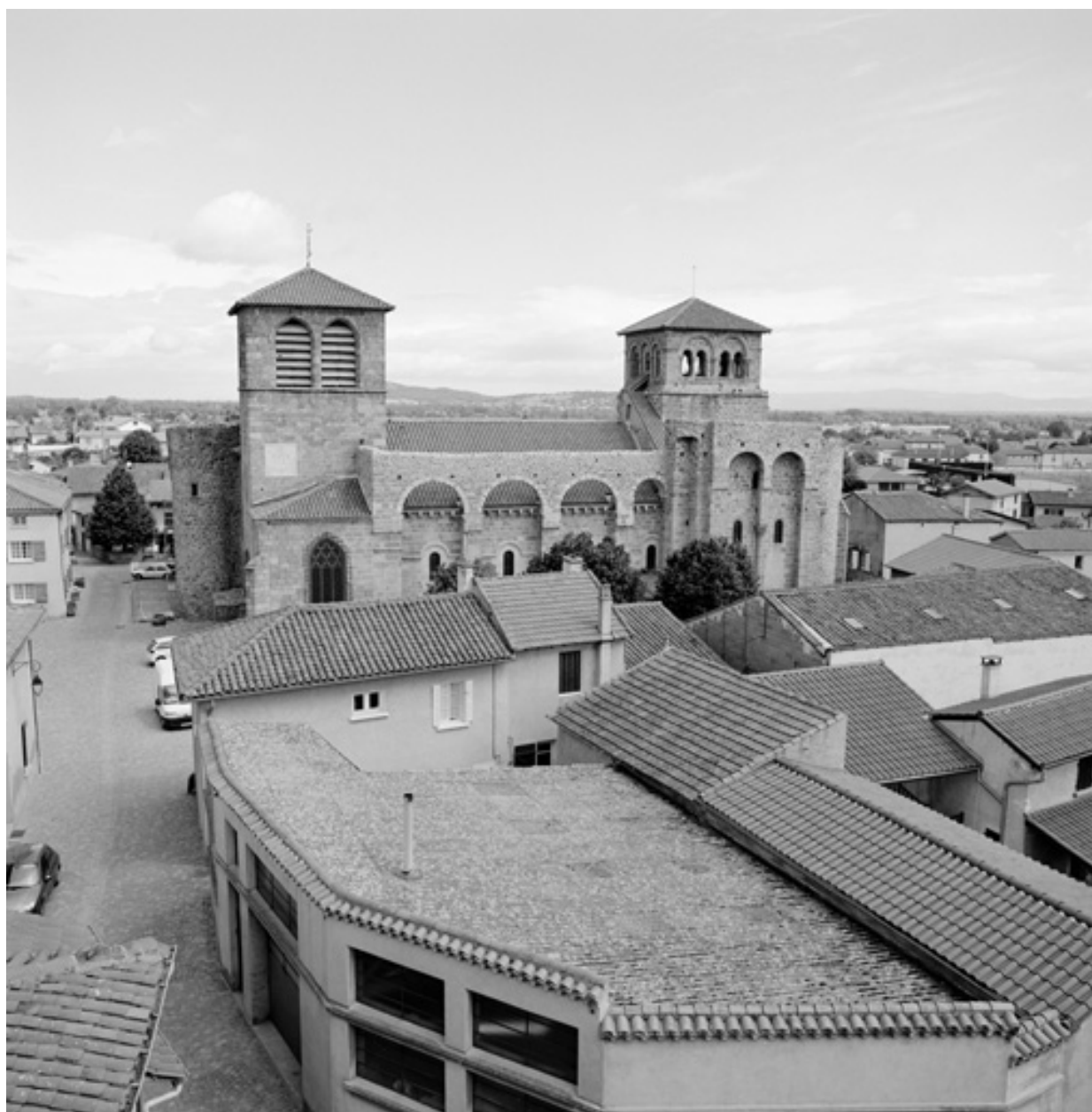
Vue générale depuis le sud.
