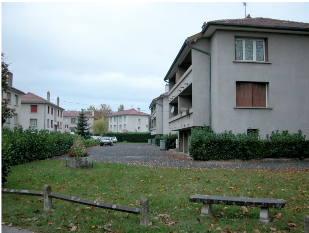
Vue d'ensemble en enfilade des bâtiments n° 1 et 2.
