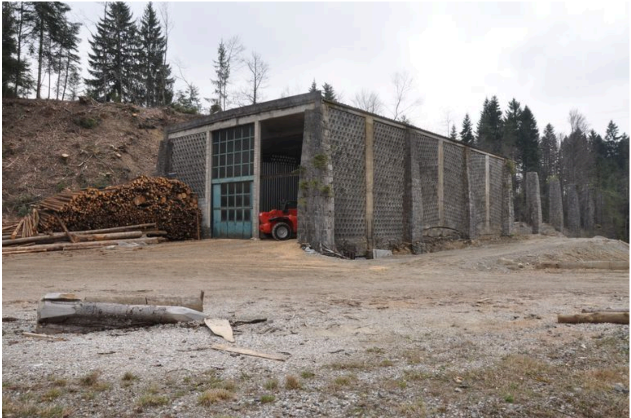
Contrevent nord-est et mur gouttereau du bâtiment de la glacière
