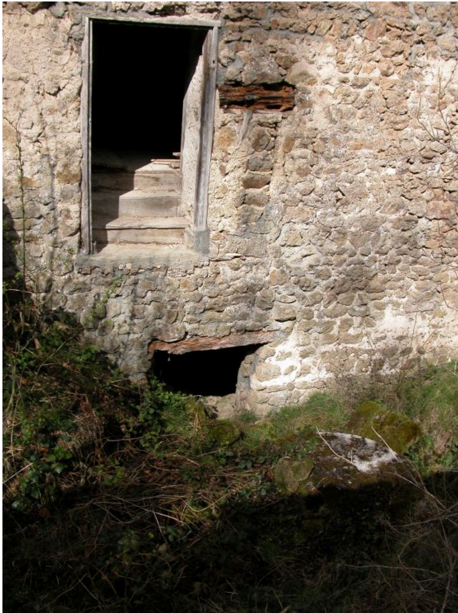
Vue partielle du mur de refend ouest du moulin.
