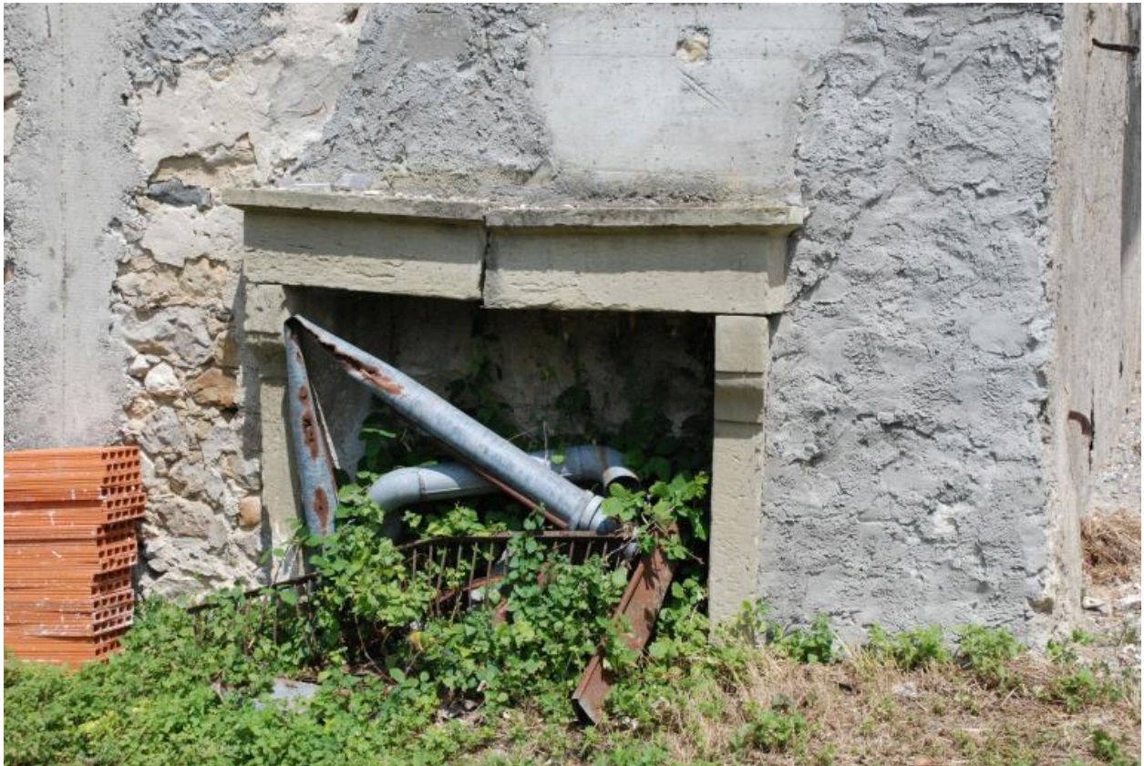
Cheminée en molasse de la cuisine d'une maison détruite, autrefois adossée au mur ouest de la ferme IA74002764.
