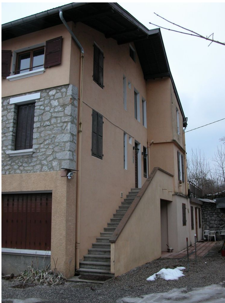
Vue de la façade arrière.
