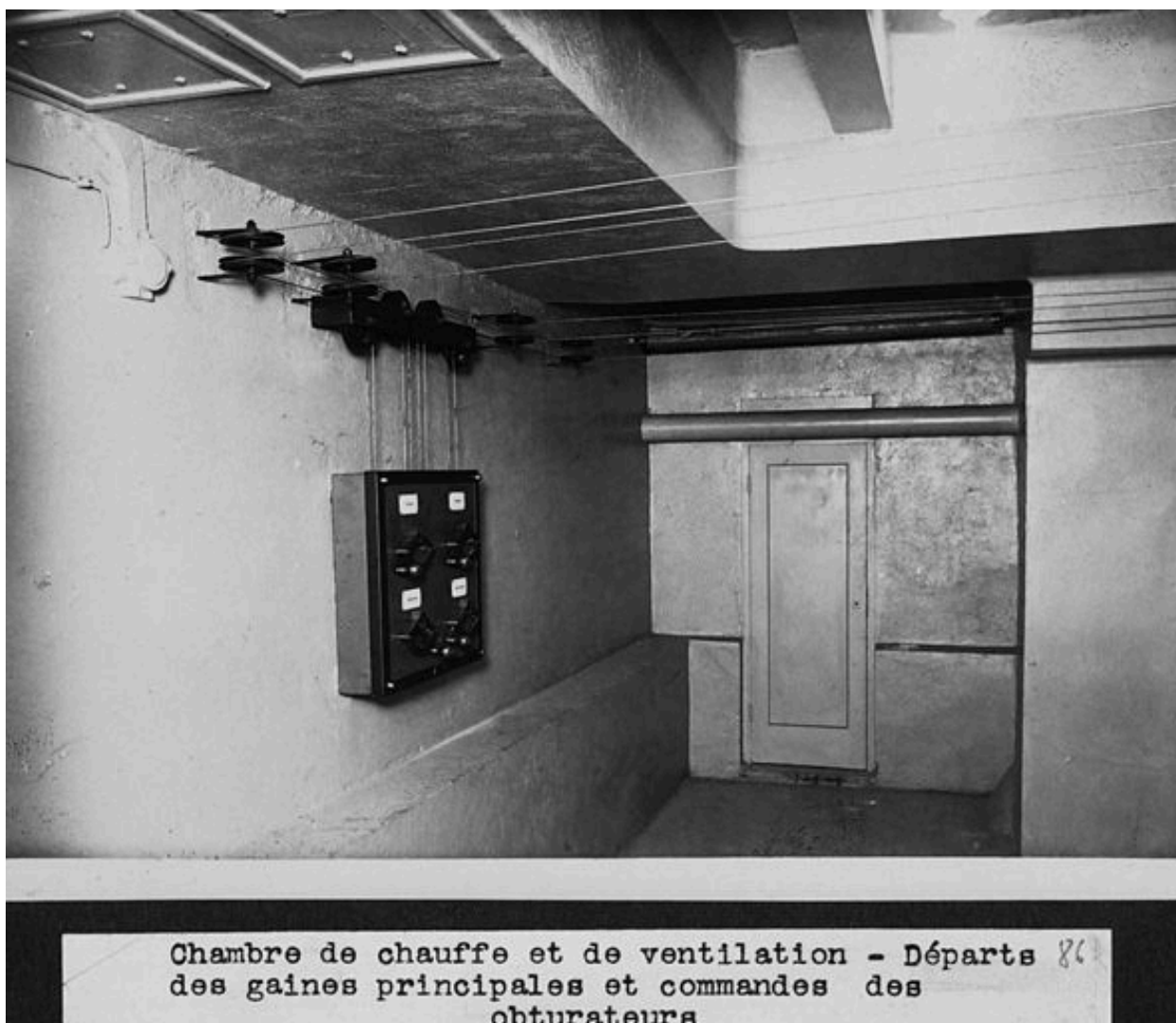
Chambre de chauffe et de ventilation. Départ des gaines principales et commandes des obturateurs. Photogr., vers 1960
