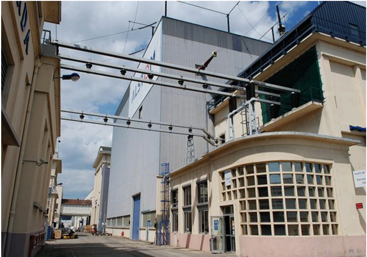
Vue des circulations extérieures
