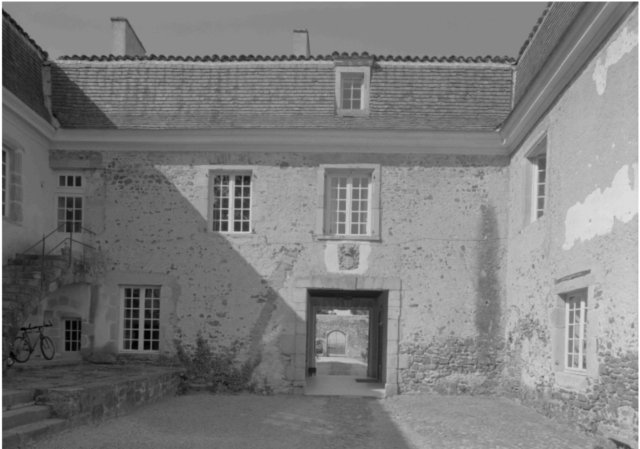
Vue générale du logis côté cour de service, du nord-ouest.
