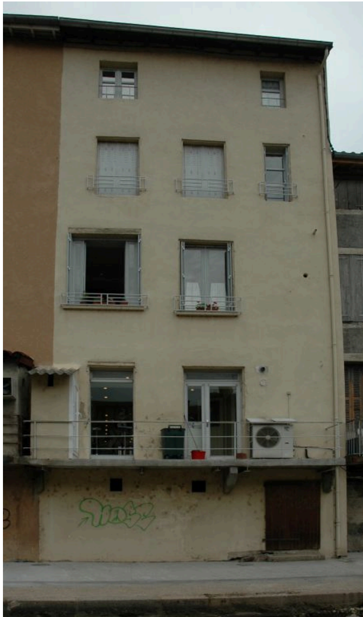
Elévation postérieure sur le quai du Vizézy.
