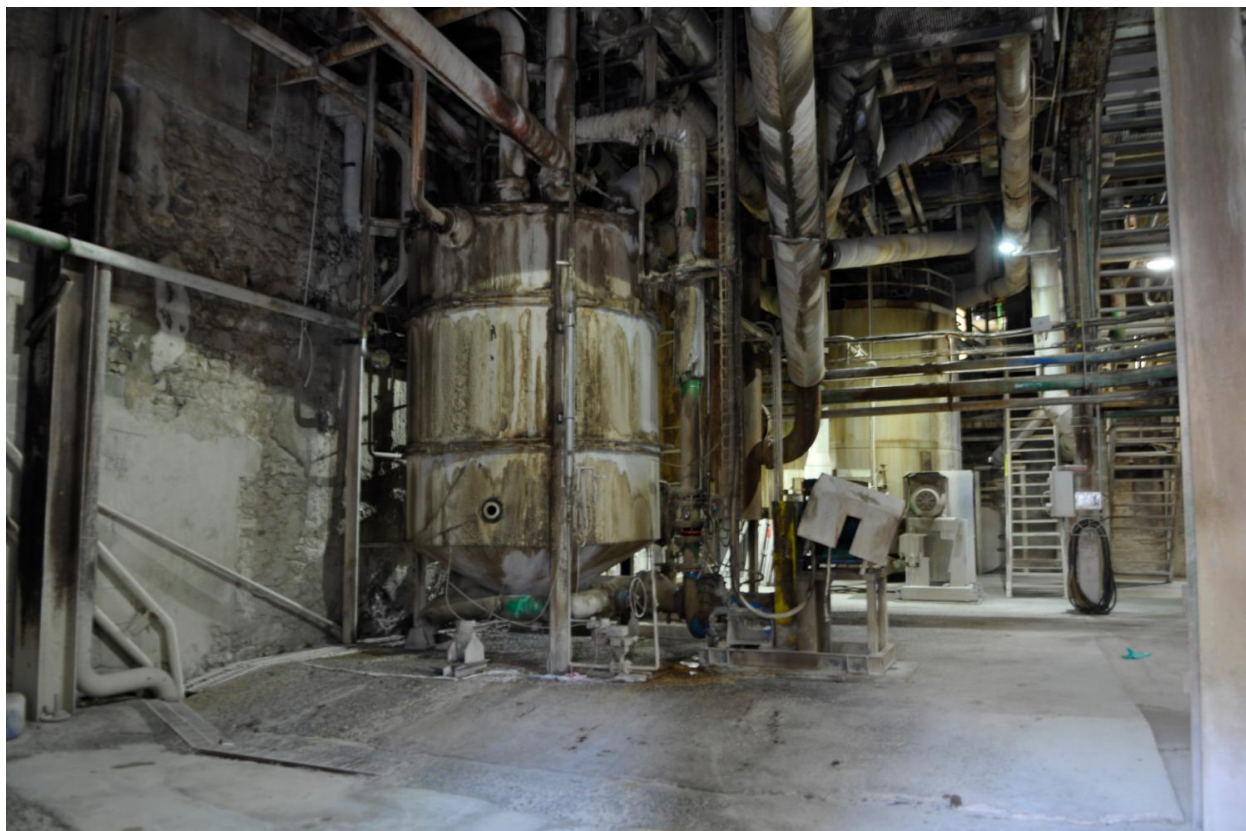
Vue de l'intérieur des ateliers
