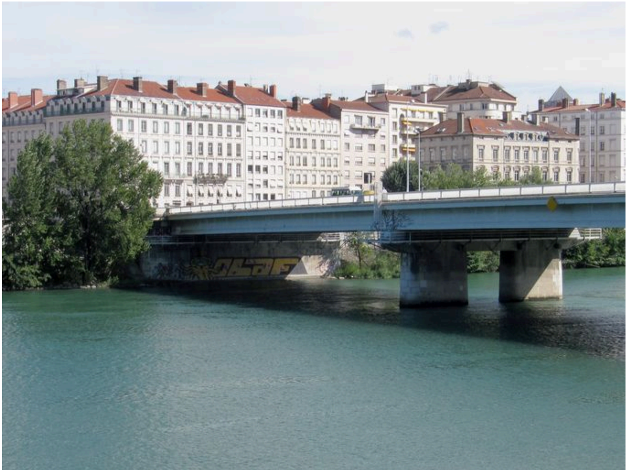
Vue partielle, travée et culée gauche, face amont (depuis la rive droite)
