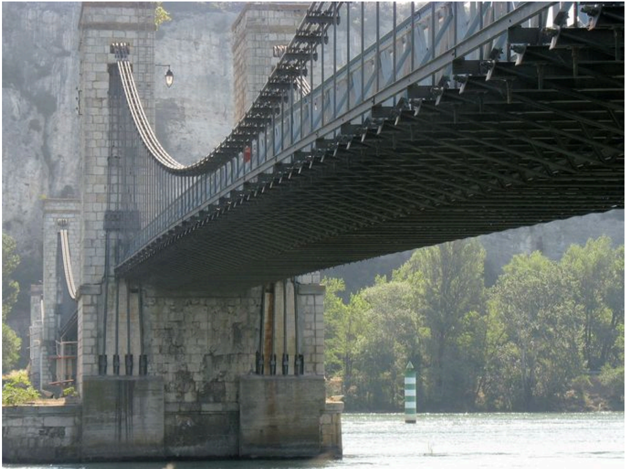
Travée rive droite (ouest), côté amont : pylône et dessous du tablier
