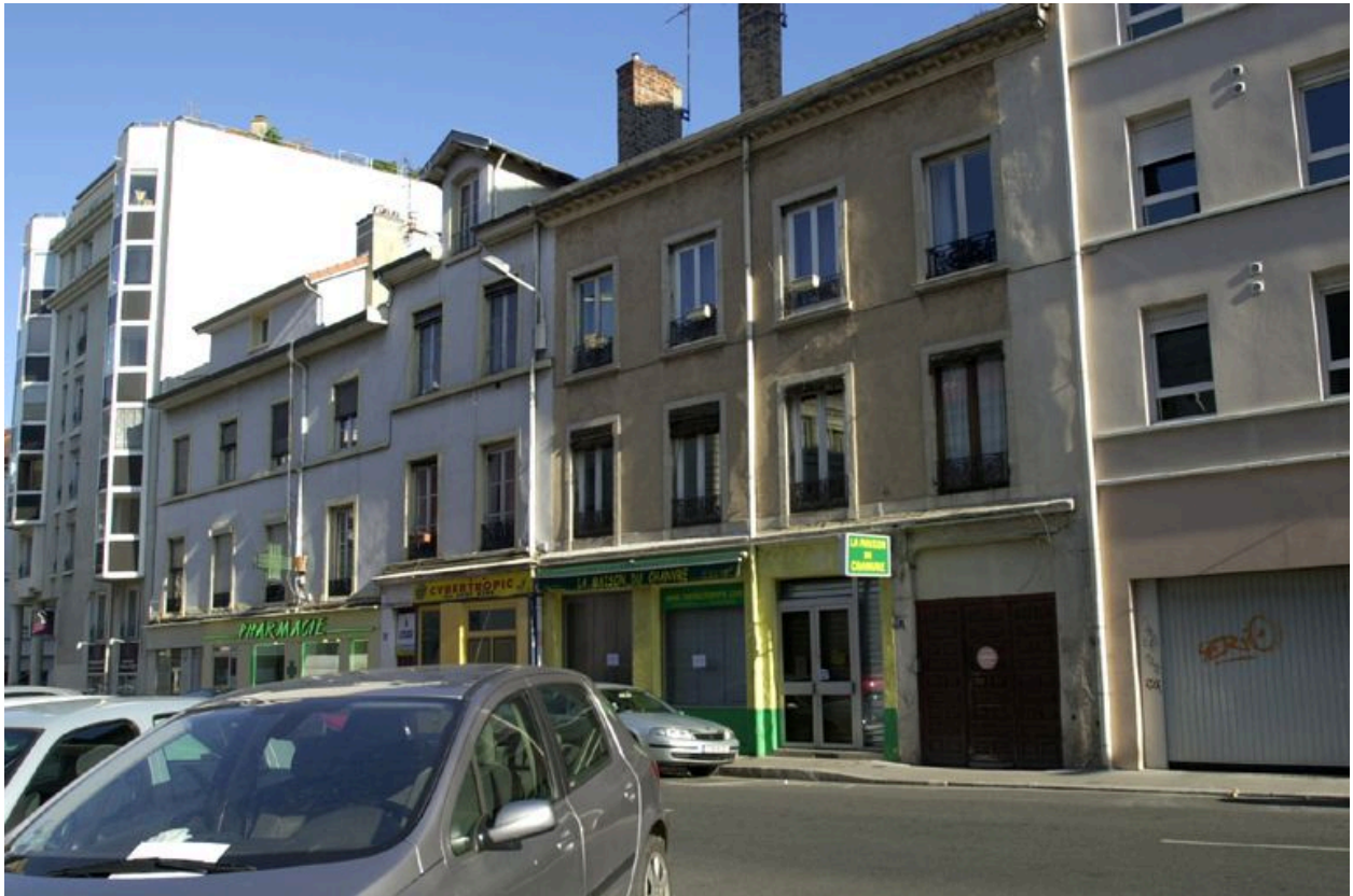
Vue générale depuis le sud est
