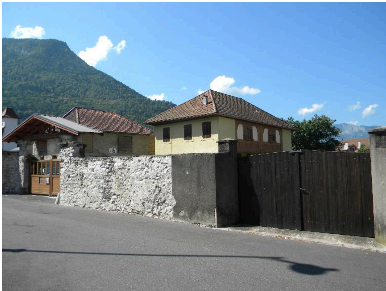
Vue d'ensemble d'une maison sur cour avec galerie en bois ouvragé (2008 D15 5378).
