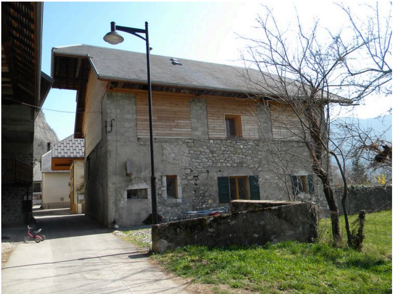
Vue de la façade ouest d'une ancienne grange-étable transformée en maison (A2 468).
