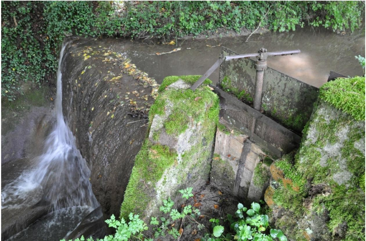
Vue du barrage sur le ruisseau la Néphaz avec le système de vannage
