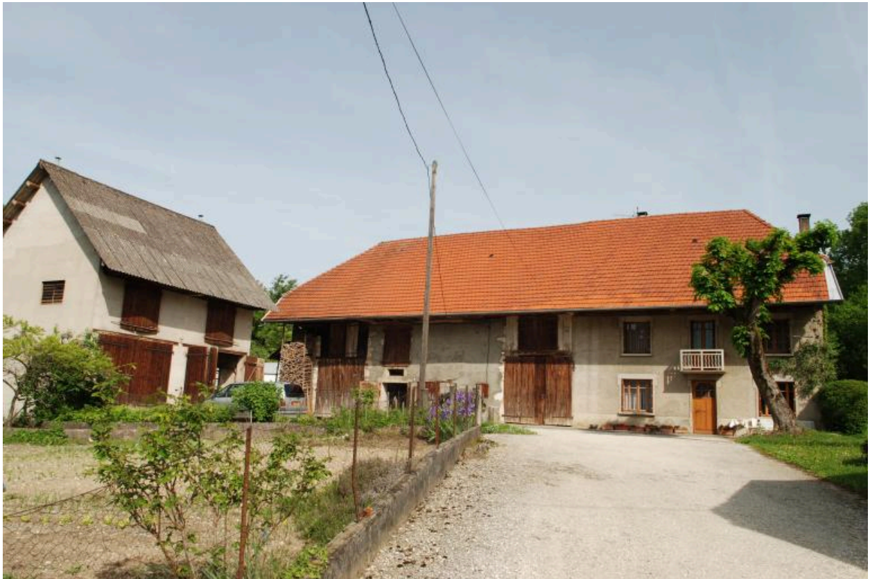
Vue d'ensemble de la ferme et de ses communs.
