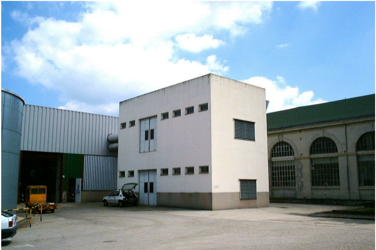
bâtiment technique du site de Giat industrie de Saint Etienne
