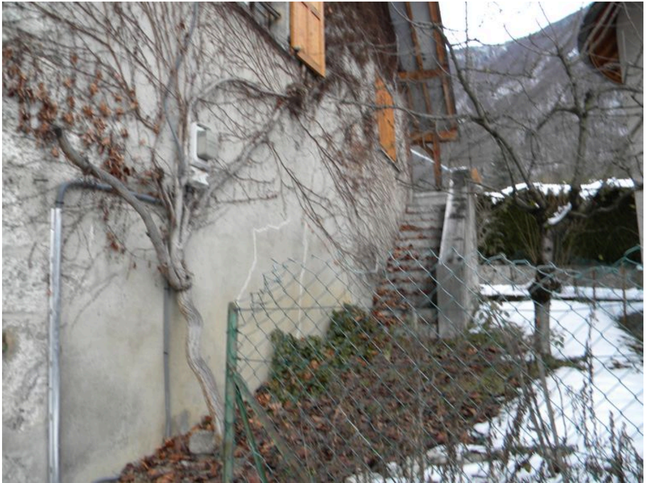
Pignon sud avec départ de l'escalier en marbre de Doussard.
